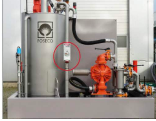
Şekil 5: Entegre zamanlayıcı kontrolü
