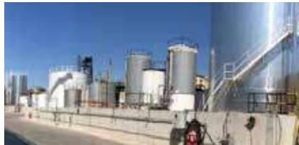
Şekil 2: Tank Sahası Revizyonu
