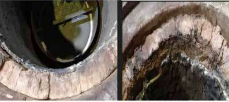
Resim 1: Ocak Üst Bölgesinde Astarı Deforme Olmuş Bölge
